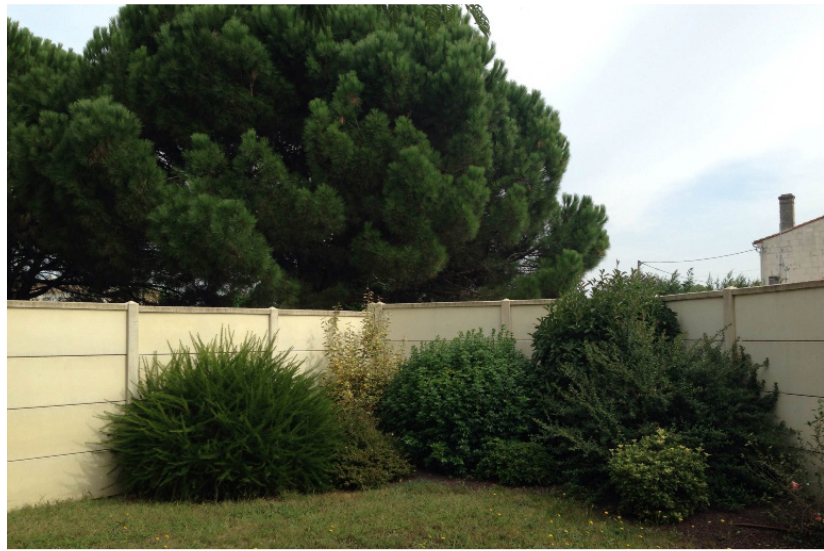
Mur plein lisse simple face ton pierre
