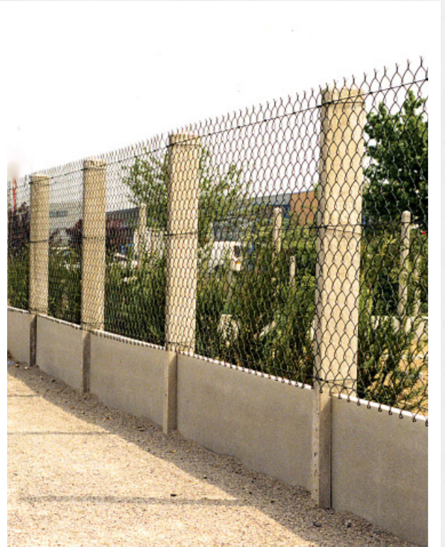
Réalisation - Poteaux mixtes - Brut non teinté
