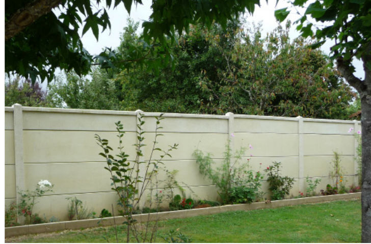
Mur plein lisse simple face ton pierre
