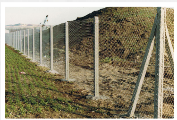
Réalisation - Clôture grillagée 8 X 8 - Poteaux à tête de diamant
